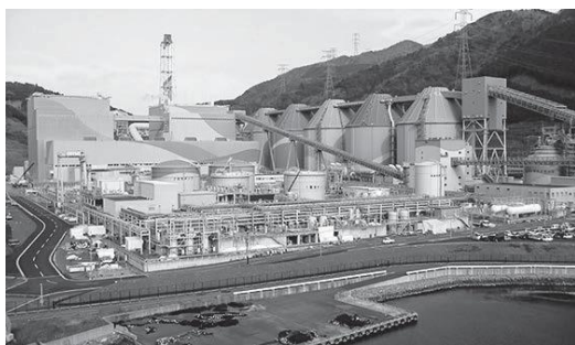
出典：関西電力（関西電力舞鶴火力発電所の全景）
