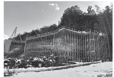
現場の様子（岡田地区）
