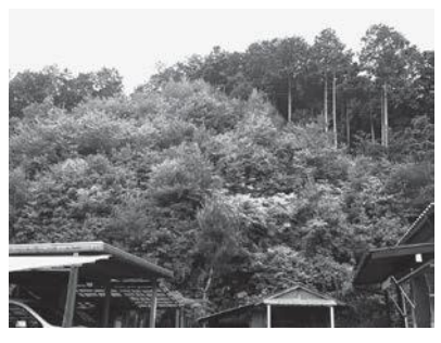
急傾斜地崩壊対策工事場所
